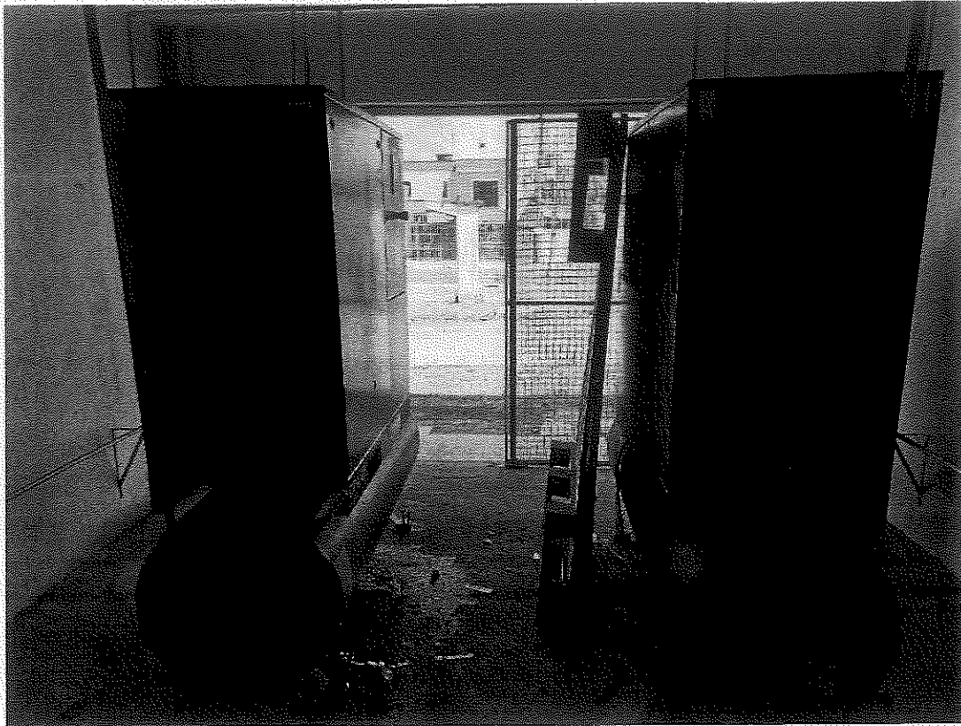
Figura 2 - Vista da Central de ar comprimido
